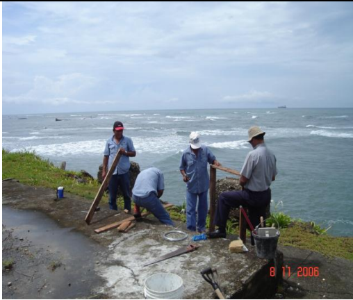
Trabajos de instalación de sistemas de captación de cloruros y dióxido de azufre ambiental en la estación rompeolas-Sherman
