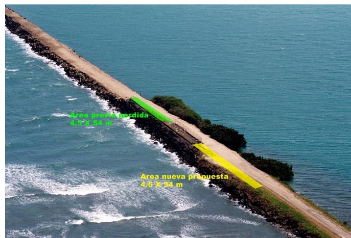
Fig. 4 Estación Rompeolas- Vista aérea
