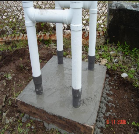
Trabajos de instalación de sistemas de captación de cloruros y dióxido de azufre ambiental en la estación rompeolas-Sherman
