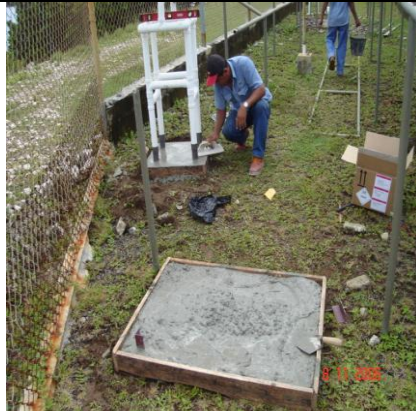
Trabajos de instalación de sistemas de captación de cloruros y dióxido de azufre ambiental en la estación rompeolas-Sherman
