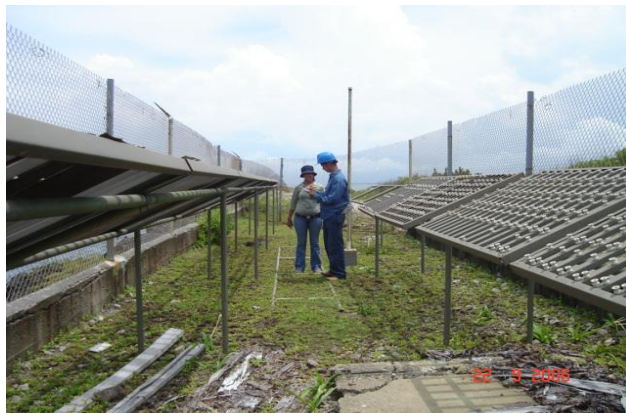
Fig. 33 Paneles para la colocación de láminas metálicas
